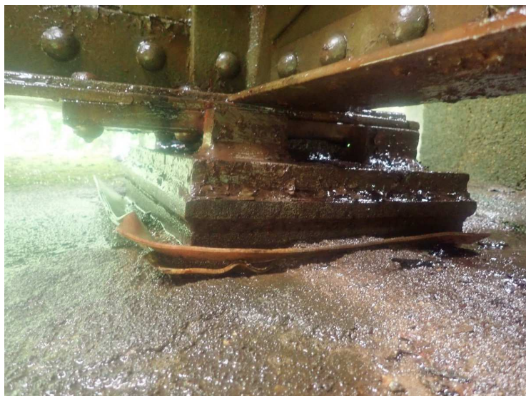
Foto č. 1 Konstrukce K 01 – nad O 01 ložisko vpravo – uvolněné
