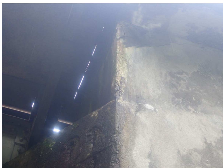
Foto č. 2 Opěra O 02 – závěrná zeď vpravo – průsak vody a pojiva
